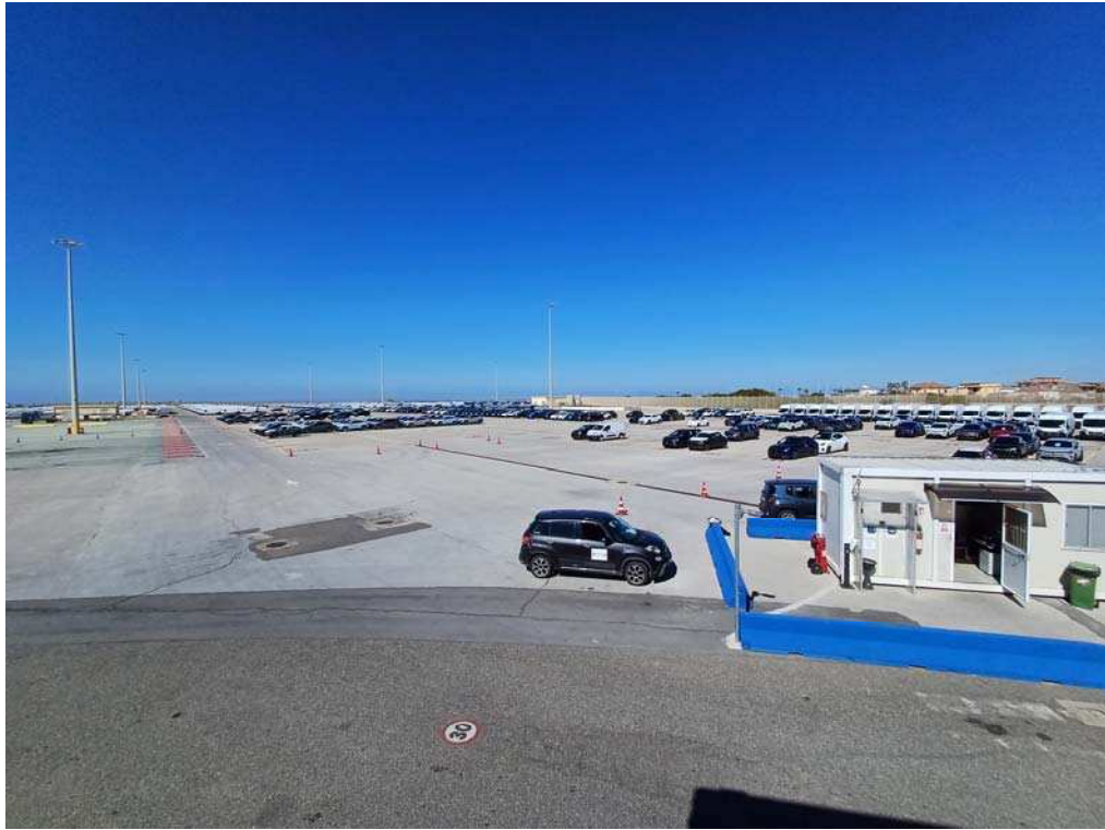
Foto n. 1 – Panoramica del sito di costruzione della nuova palazzina vista dall'attuale edificio uffici e spogliatoi
